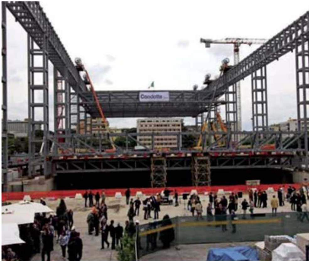
Centro Congressi Il cantiere della «Nuvola» di Fuksas, all'Eur, che verrà inaugurata nel 2013
